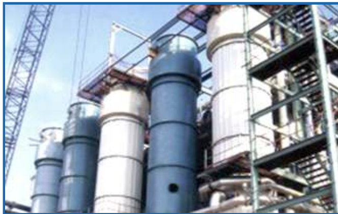
Evaporador de Película Descendente (Calentamiento de la superficie 500m 2 a 6,000m 2 )
